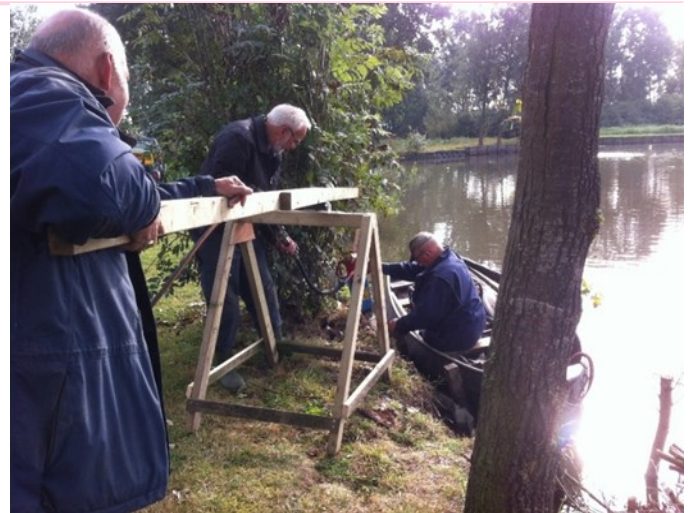
Koos heeft een bok met hefboom ontworpen om de palenrammer op de hardhouten palen te laten zakken. Nico tilt en Hennie stuurt.
