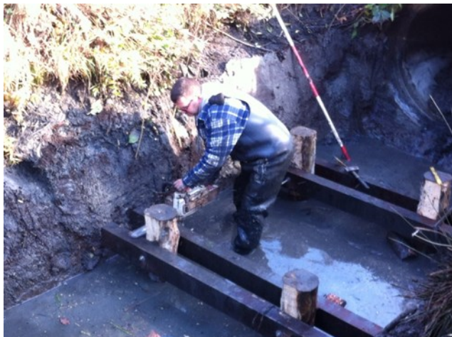
Peter maakt de fundering voor de betonnen voet
