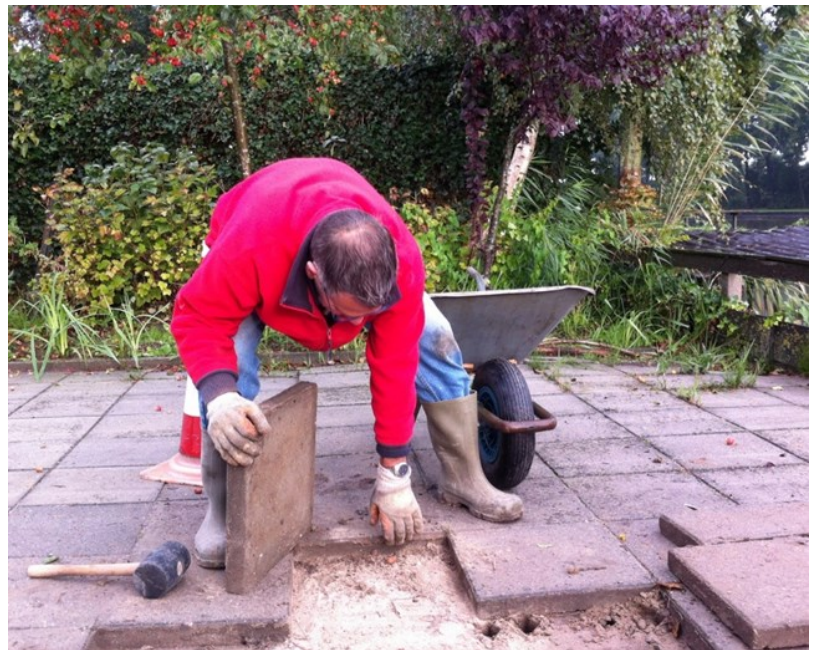
De Straatkolk bij het gebouw was geheel verzakt. Via internet werd een identiek exemplaar gevonden en Teus legt hier de laatste tegels er omheen!!
